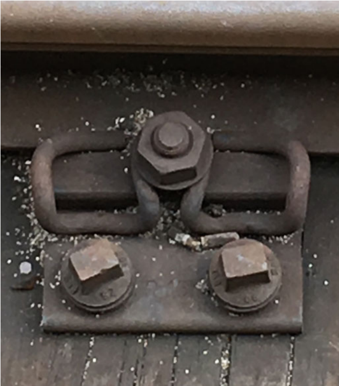
Abb. 2.1 Form- (quer zur Schiene) und kraftschlüssige Verbindungen (längs zur Schiene) bei einer Eisenbahnschiene (Foto: Dr. Jürgen Klingen, Aboso-Consulting).
