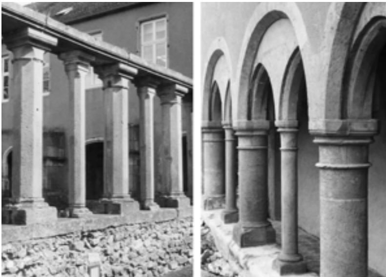
□ 5 Metz, Details der Kreuzgänge der Benediktinerinnenabtei St-Pierre-aux-Nonnains (mit Kolonnaden) und der Klarissen (mit Arkaden), Mitte 13. Jh. und um 1258
