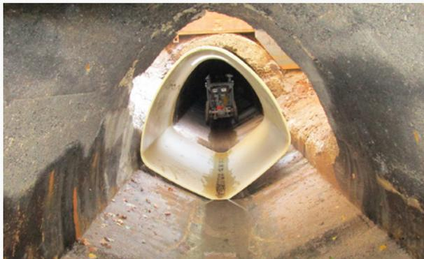
72 Der im Jahr 1934 aus Ortbeton gebaute Entlastungskanal RÜ 99 wird mit GFK-Kurzrohren saniert
