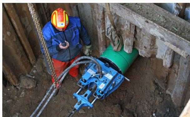
68 Berstlining in Dresden: Der Aufweitkopf DN 500 schneidet das alte Eiprofil-Rohr aus Beton mühelos
