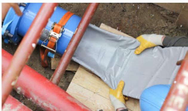
54 Einzug eines Druckschlauch-Liners mit UV-lichtdichter Außenbeschichtung
