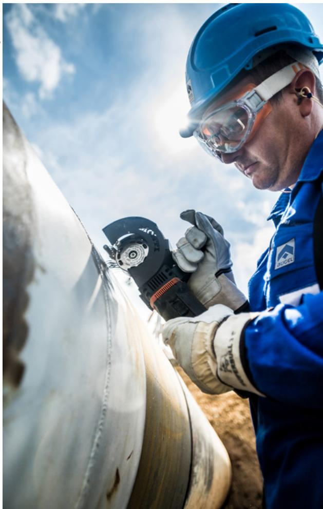
**Bild 1:** Oberflächenvorbereitungsarbeiten im Pipelinebau
