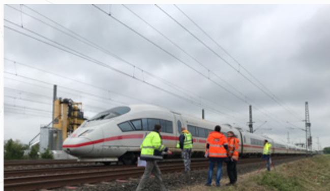
81 900 m neuer Mischwasserkanal unter Bahnanlagen und Bundesstraßen
