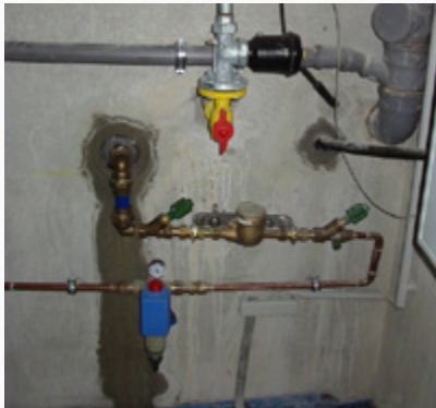
94 Regelwerk im Bereich Hauseinführung
