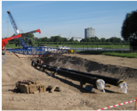
48 Dükerbau unter dem Rhein in Düsseldorf erfolgreich abgeschlossen
