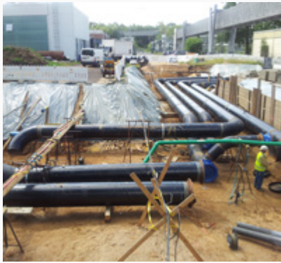
42 Ausbau der Infrastruktur am DLR-Standort Köln
