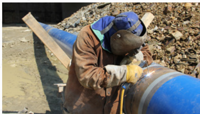
26 Druckwasserleitung DN 300 in Kreuzungsbauwerk in Velbert verlegt
