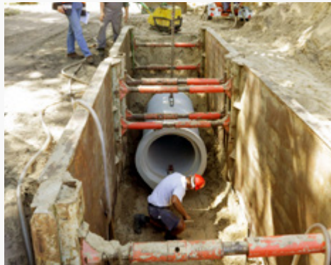
116 Kontrolle der Lastannahmen: Rohrstatik – Rohreinbau
