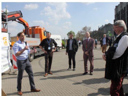
Liveinstallation eines SF-Schachtliners DN 1000
