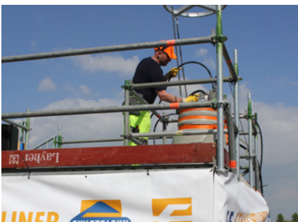
Außenvorführung der Firma Swietelsky Faber
