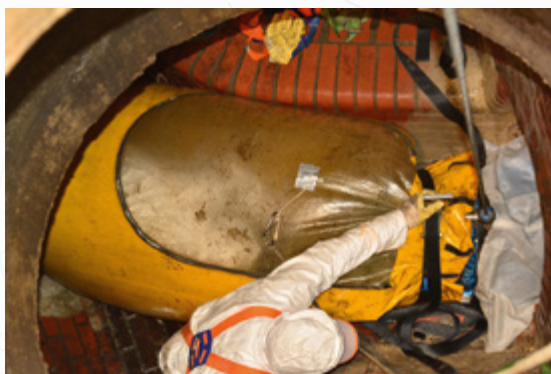
28 Über den Umgang mit Mängeln in der Kanalisierung
