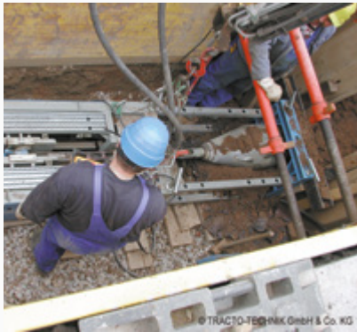
110 Nachhaltige Rohrerneuerung mit Berstverfahren
