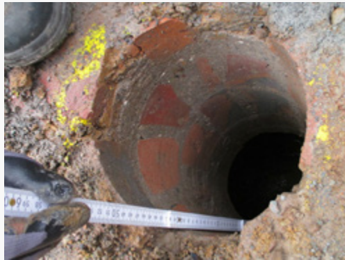
153 Neue technische Lösung für Anschlüsse an Hauptrohre mit Wanddicken von 180 bis 560 mm
