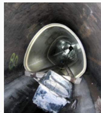
60 Einbau von GFK-Profilen bei einer Sanierungsmaßnahme der Stadt Radebeul
