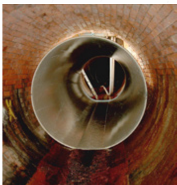
16 Neu erschienen: Das RSV-Merkblatt 3.2 „Verfüllen von Ringräumen“
