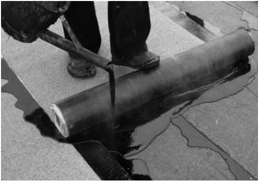
Bild 5. Verlegung von Bitumenbahnen im Gießverfahren, hier auf einer Stahlbetondecke
