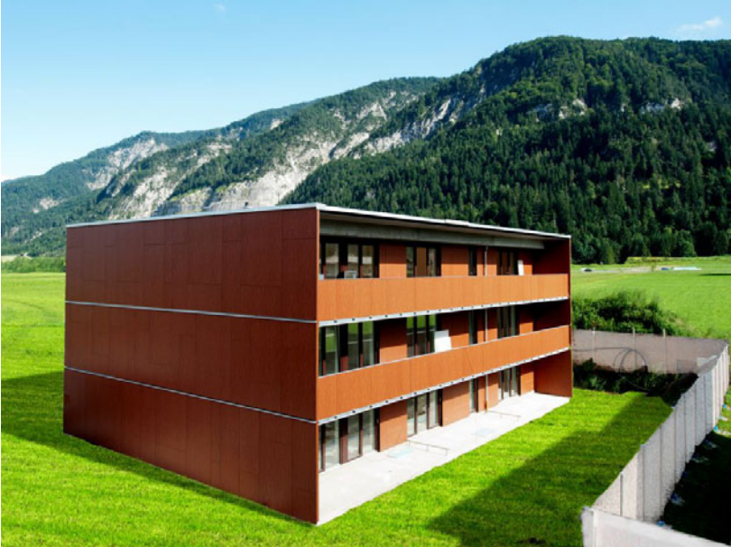
Bild 1-1 Einer von 2 Baukörpern einer Wohnanlage mit 23 Mietkaufwohnungen in Kundl in Tirol. Das in Holz- und Massivbauweise 2011/12 errichtete Gebäude vereint hohe Energieeffizienz und nachgewiesenermaßen gute Werte für die Qualität der Innenraumluft. Bedingung für die Umsetzung war, dass die Kosten durch die innenraumhygienischen Maßnahmen nicht über die für sozialen Wohnungsbau maßgebliche Grenze steigen.
