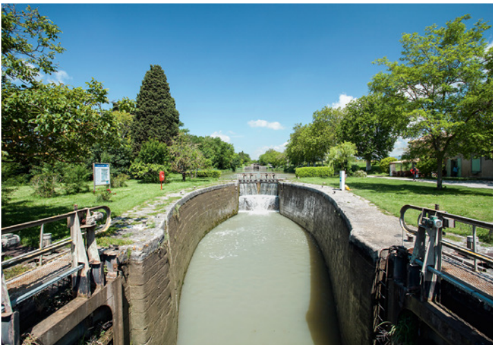
Die Schleusenbecken am Canal du Midi haben größtenteils noch die ursprüngliche ovale Form.
