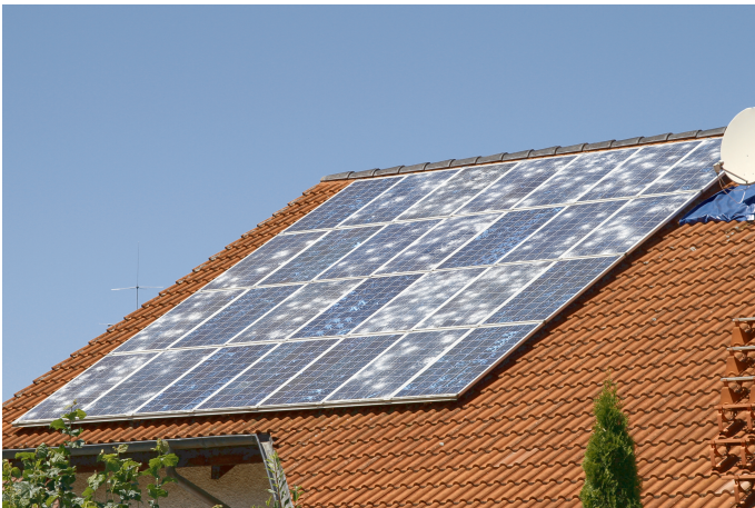
Abbildung 2: Zerstörte Solaranlagen nach dem Hagelsturm vom 28. Juli 2013
