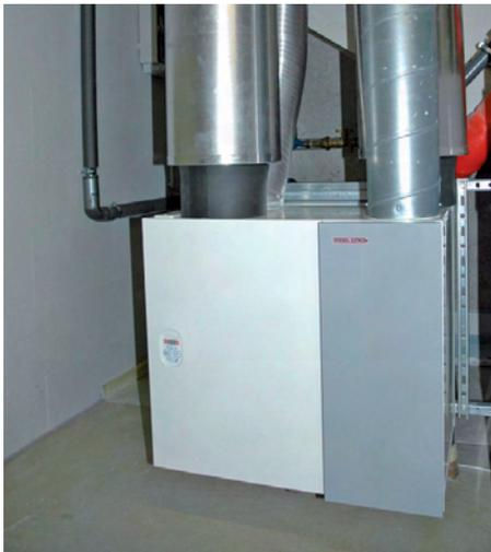
**Abb. 2.9:** Kontrollierte Raumlüftung mit Wärmerückgewinnung und KNX-Steuerung.
