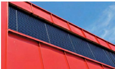
**Abb. 2.7:** Wärmeschutz im Sommer und zusätzliche Heizenergie im Winter – durch automatische Jalousien.
