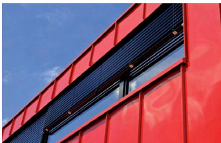
**Abb. 2.6:** Automatische Steuerung von Jalousien in Abhängigkeit von Sonnenstand und Wetter.
