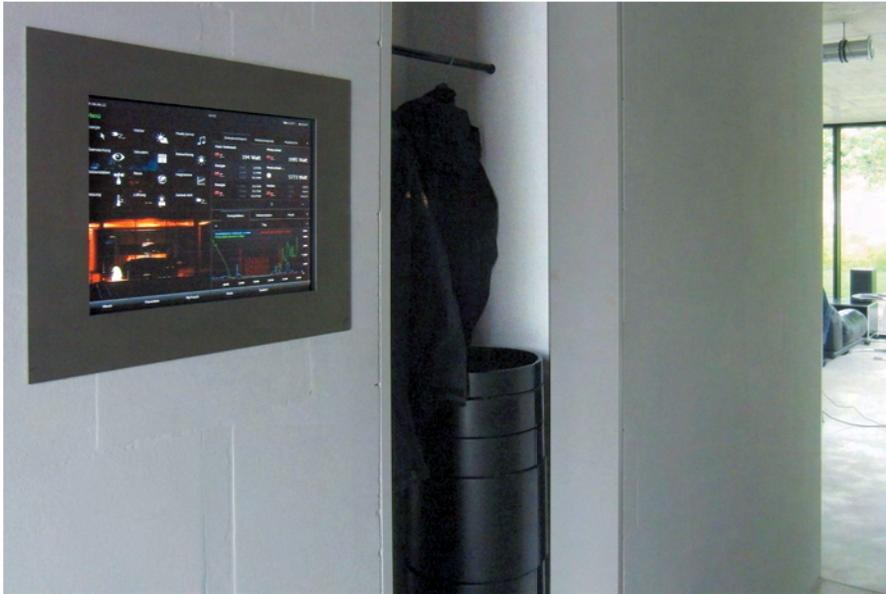
Abb. 2.2: Bedienung und Darstellung über Touchscreen – fortgeschrittene Ausbaustufe einer KNX-Vernetzung.
