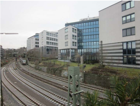
Bild 6. Gebäude Presselstraße 10 und 12
