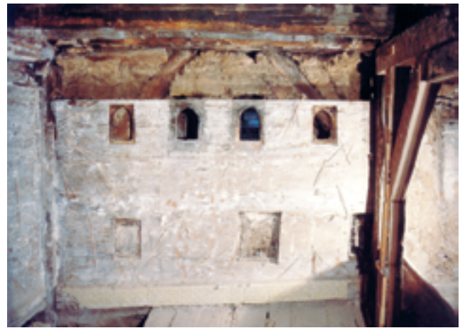
Abb. 1.13: Esslingen, Hafenmarkt 8, zweites Obergeschoss: Lichtöffnungen einer Bohlenstube aus der zweiten Hälfte des 13. Jahrhunderts: Diese Bohlenwand war ursprünglich eine Außenwand und wurde hier in Zweitverwendung eingesetzt. (Quelle: Ewald/Köhle-Hezinger/Könekamp, 1991, S. 35)
