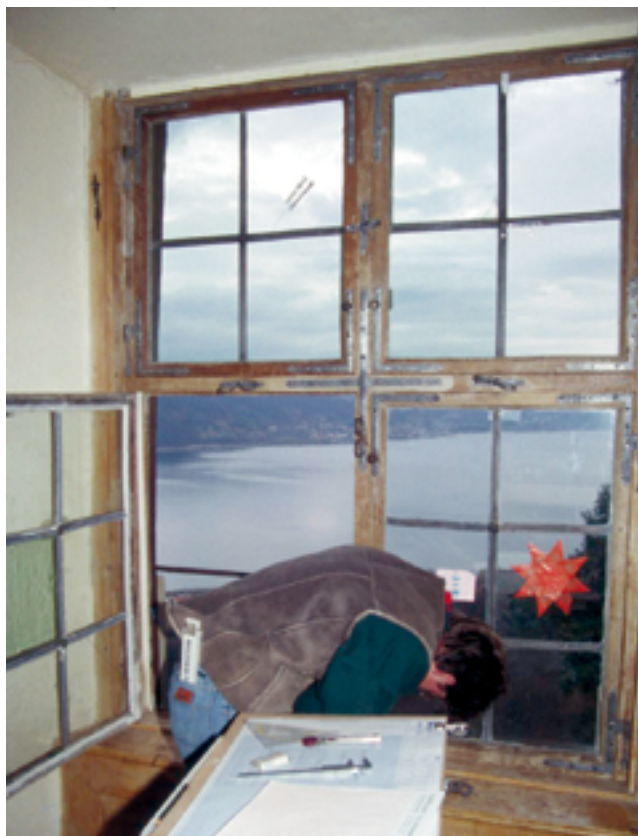
Abb. 1.26: Bodman, Kloster Frauenberg, erbaut 1611: Verglasung und Binnengliederung des bauzeitlichen Fensters wurden barockisiert. Im unteren Flügel waren ursprünglich zusätzliche Lüftungsschieber angeordnet.
