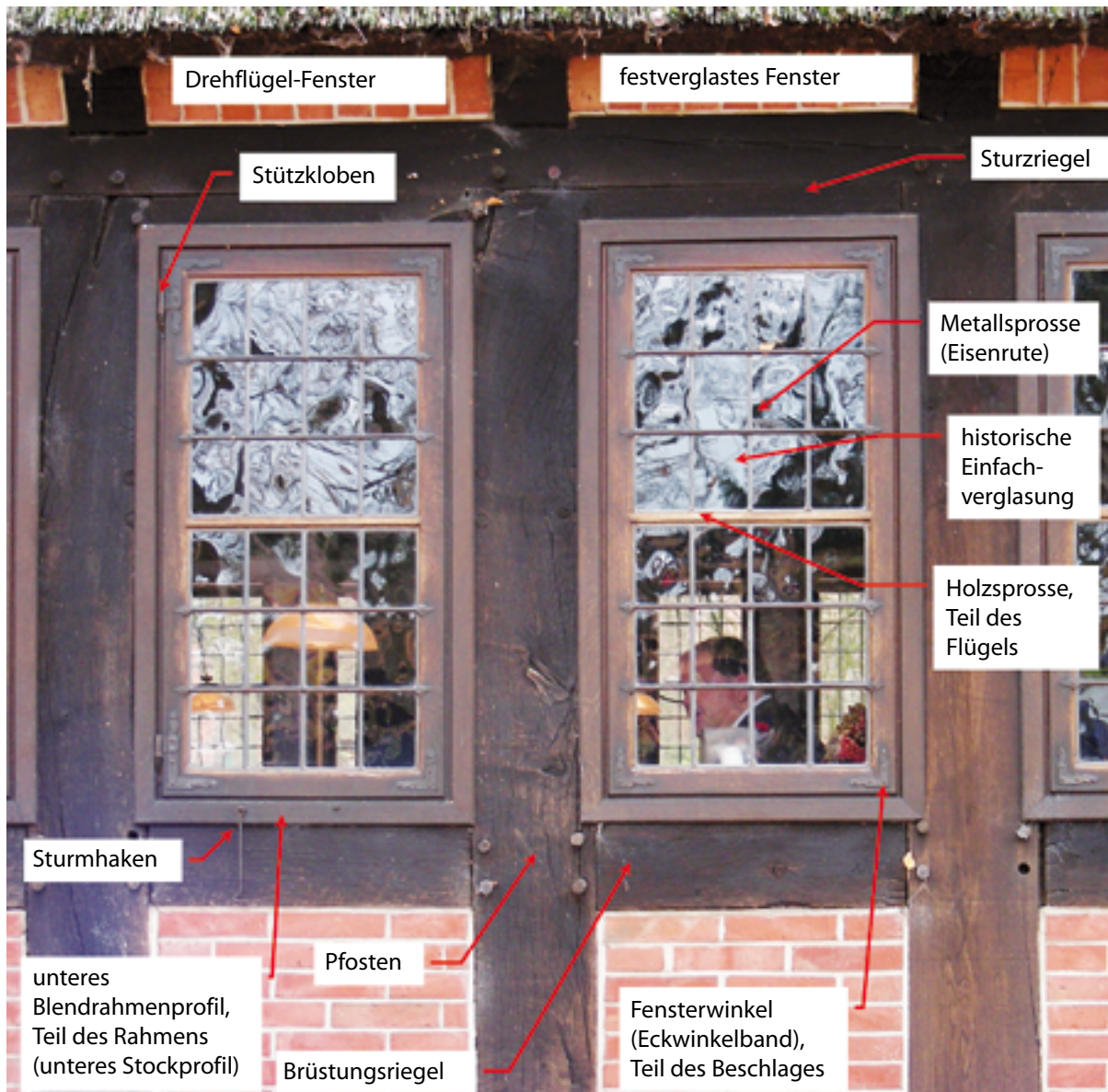
Abb. 5: Einfachfenster im Fachwerk in geschützter Einbaulage (historische Gaststube im Freilichtmuseum Cloppenburg)
