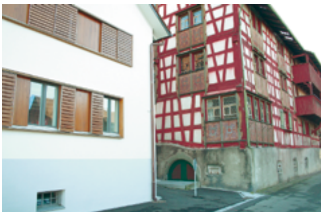
Abb. 1.38: Bischofszell, Schmalzgasse, vor 1743: Ziehläden gehören zur Standardausstattung. Der Fensterverschluss selbst ist nicht dargestellt. (Quelle: Knoepfli, 1969, S. 41)
