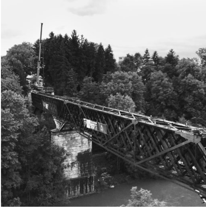
Abb. 1.6 Eisenbahnbrücke über die Iller in Kempten (Quelle: Z & M 3D-Welt).
